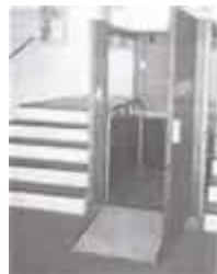
Modello di piattaforma elevatrice per superare dislivelli non superiori a 80-100 cm.
